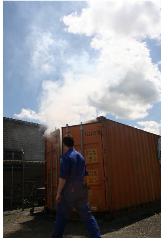
Marc Vujicic prüft das Kühlsystem des Schalldämpfers nach einem Testlauf
